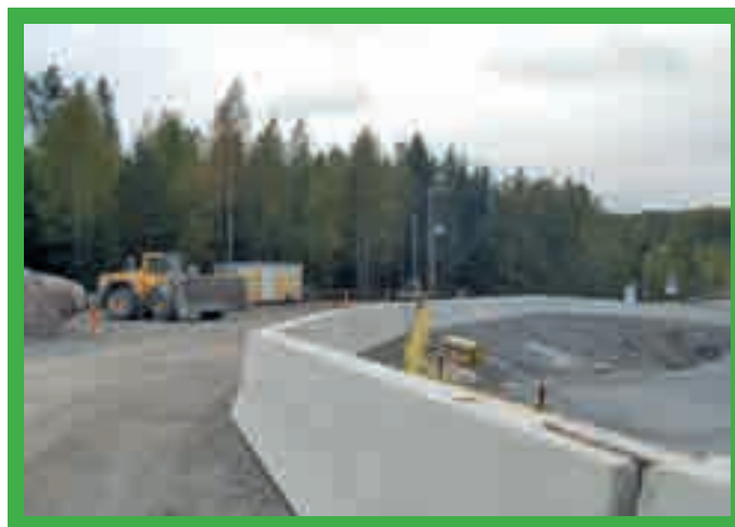
Przykład obwałowania z użyciem betonowych zabezpieczeń.
