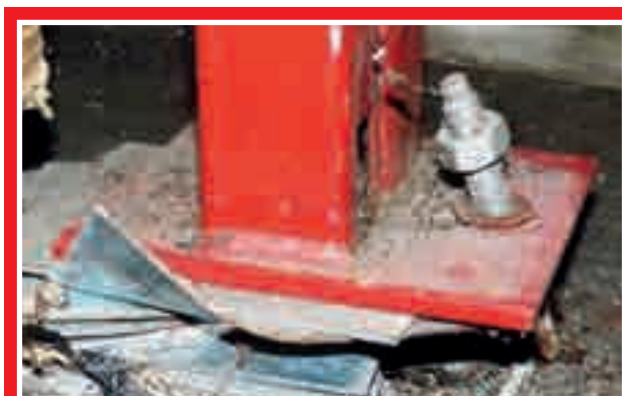
Mocowanie do podłoża – uszkodzone lub brak mocowania.
