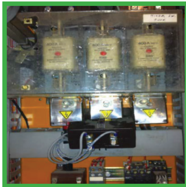
Wszystkie punkty styku znajdujące się pod napięciem są osłonięte i przykryte.
