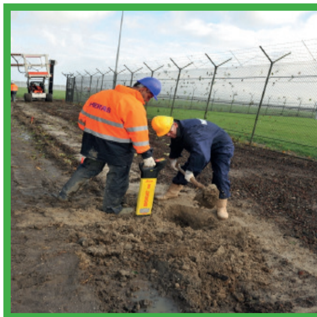
Weryfikacja występowania instalacji podziemnych przed rozpoczęciem prac.
