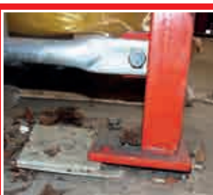
Mocowanie do podłoża – uszkodzone lub brak mocowania.
