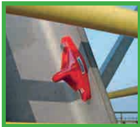
Instalacja punktów kotwienia w wymaganych miejscach.
