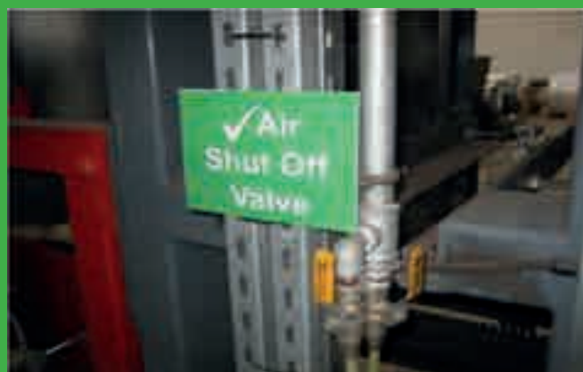
Opis punktu blokowania zaworu energii pneumatycznej.
