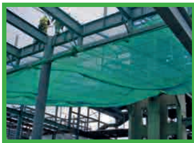
Zamontowana siatka zabezpieczająca przed upadkiem.
