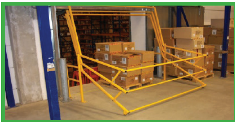
System zamykanej klatki zabezpieczającej, który zapewnia ochronę przed upadkami z wysokości.
