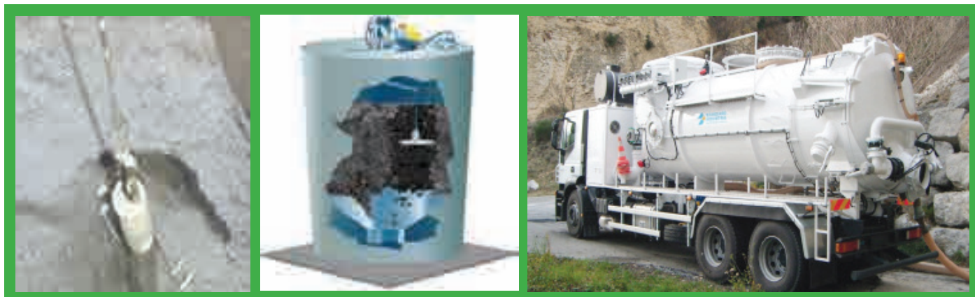
31 października 2017r.: Pracownik wykonawcy podczas czyszczenia wszedł do zesypu. W wyniku błędu zasuwa nad jego głową została otwarta co spowodowało jego zasypanie, a w konsekwencji śmierć pracownika.
