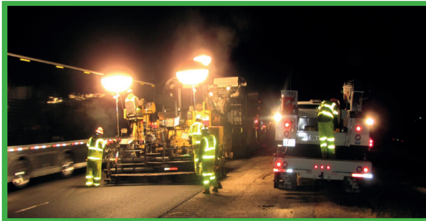
Układanie nawierzchni drogowych nocą podczas ruchu pojazdów.
