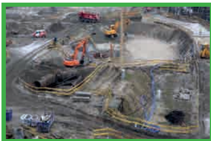
Organizacja transportu na placu budowy.
