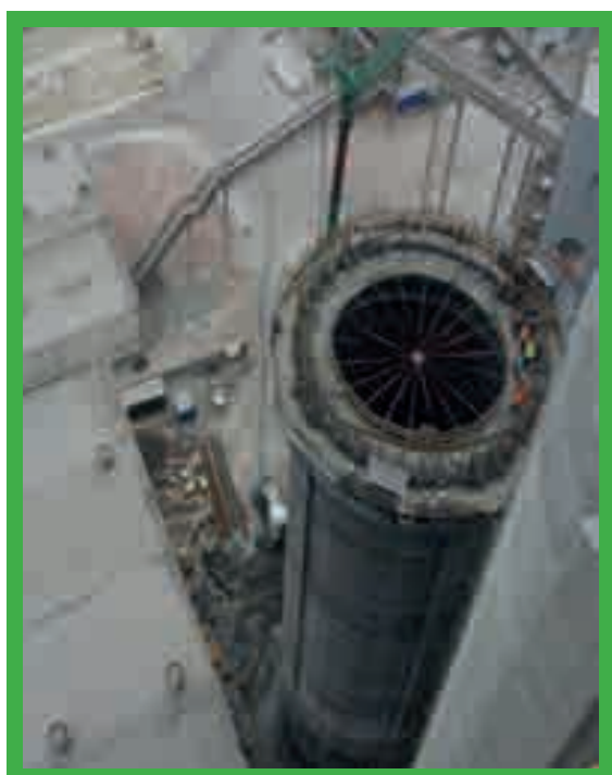
Budowa silosu mączki surowcowej.
