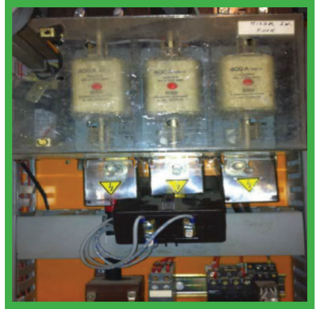
Wszystkie punkty styku znajdujące się pod napięciem są osłonięte i przykryte.
