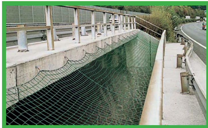
Siatka zabezpieczająca przed upadkiem z wysokości.
