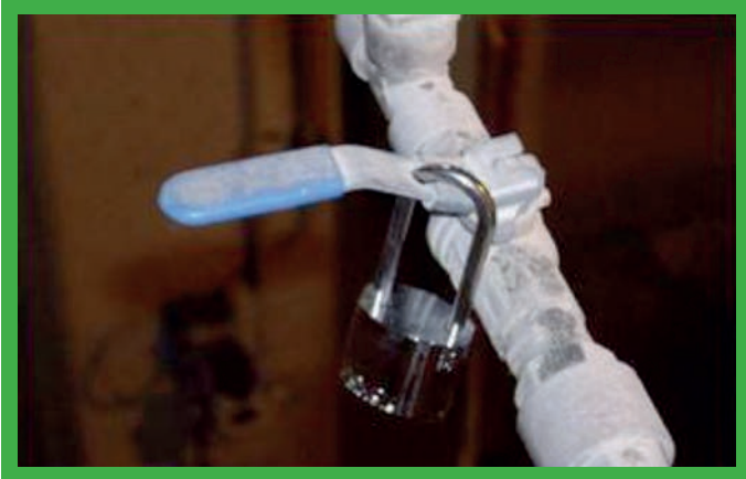
Zablokowanie zaworu energii pneumatycznej.
