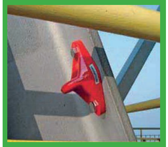
Instalacja punktów kotwienia w wymaganych miejscach.
