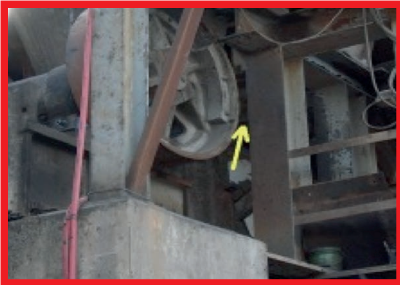
Wypadek śmiertelny w Grupie – Opis wypadku z 2006 r.: Podczas podnoszenia ładunku pracownik nadzoru został zgnieciony między podnoszonym ładunkiem a stalową belką.
