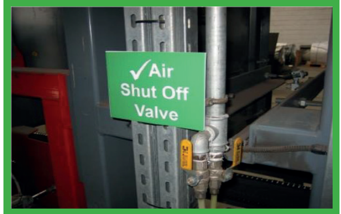
Opis punktu blokowania zaworu energii pneumatycznej.
