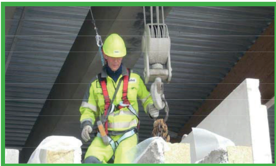
System kotwicy do zabezpieczenia i odpinania zawiesi do podnoszenia.
