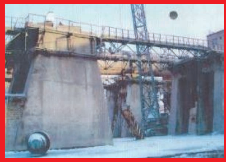
Wypadek śmiertelny w Grupie – Opis wypadku z 2005 r.: Wykonawca spadł z ciągu pieszego w czasie nadzorowania prac montażowych.
