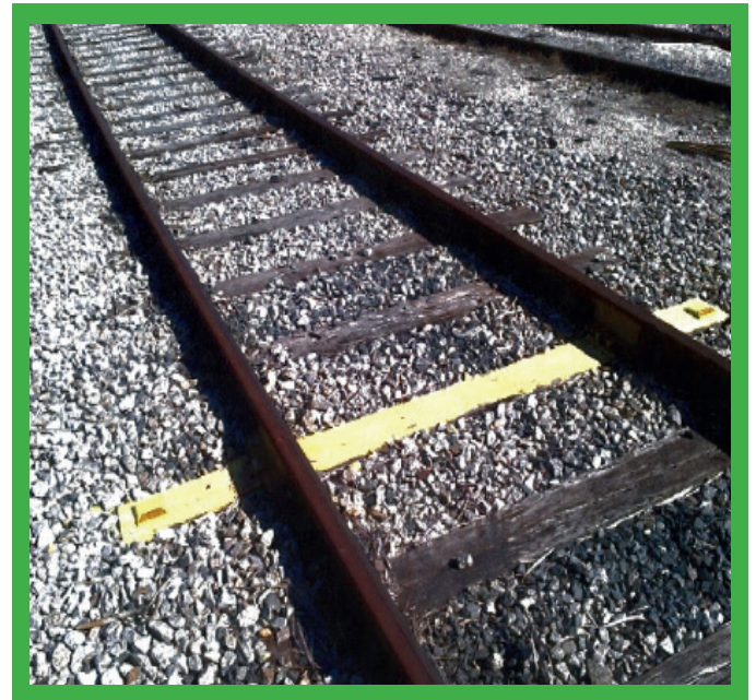
Znaczniki określające wymaganą pozycję zatrzymania wagonów.
