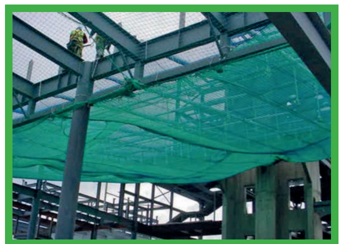
Zamontowana siatka zabezpieczająca przed upadkiem.
