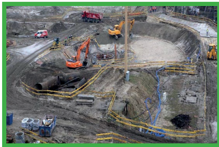
Organizacja transportu na placu budowy.
