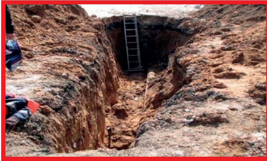
Wypadek śmiertelny – 2009 r.: Zawalenie się wykopu (2,1 m) o niezabezpieczonych ścianach.
