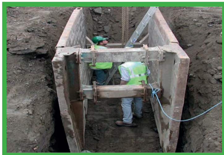
Przykładowe zabezpieczenie ścian wykopu przed obsunięciem.
