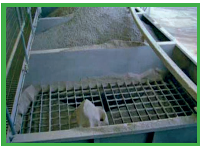
Zainstalowane kraty zabezpieczające.
