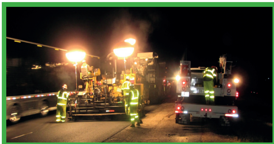
Układanie nawierzchni drogowych nocą podczas ruchu pojazdów.
