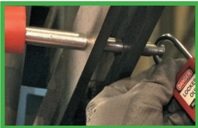
Zabezpieczenie mechaniczne – blokada zabezpieczająca przesuwne drzwi (blokada mechaniczna + kłódka).
