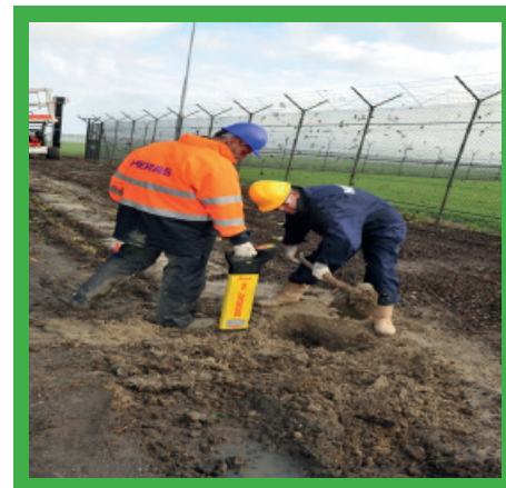
Weryfikacja występowania instalacji podziemnych przed rozpoczęciem prac.
